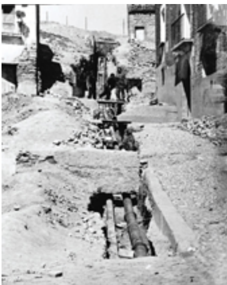
Trabajos en la tubería de distribución de agua.
