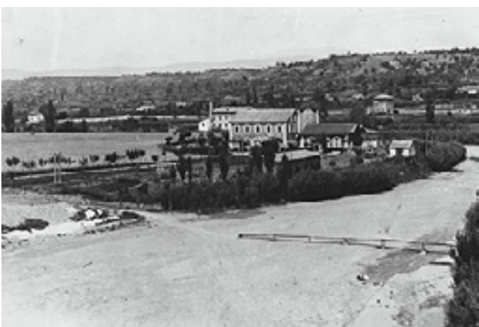
Vista de las instalaciones de los depósitos a principios del siglo XX.
